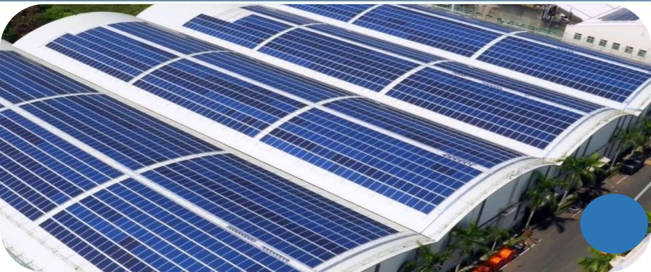
低角度屋面翹角設計 (專利夾具及拉索防颱固定)
