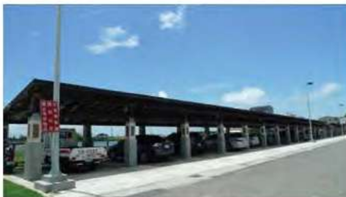
北門遊客中心停車棚的屋頂設置太陽光電系統，充分利用當地日照資源。
